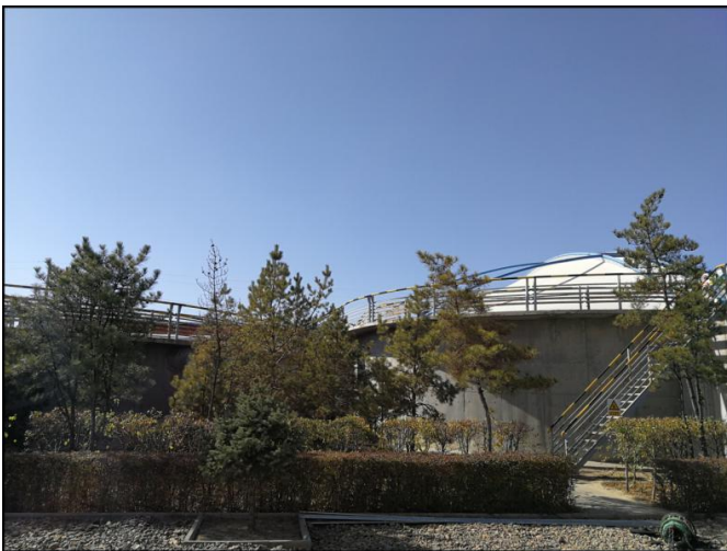
厂区污水处理站
