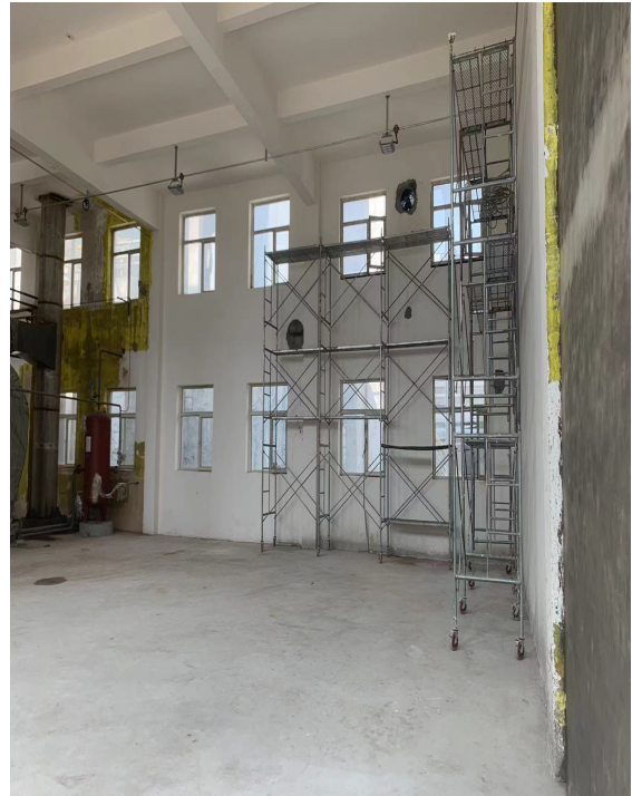
锅炉房预留空地
