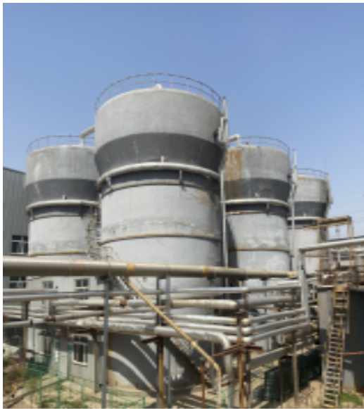
污水处理车间现状
