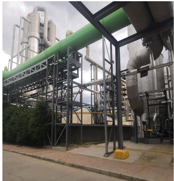
污水处理车间现状
