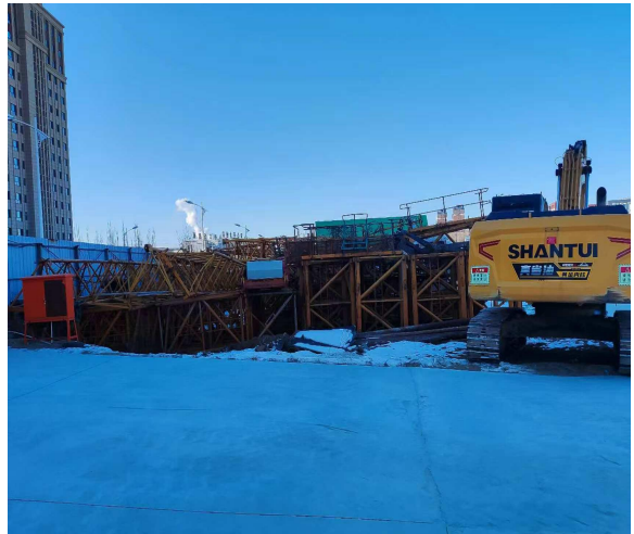
施工临建（临时施工区）
