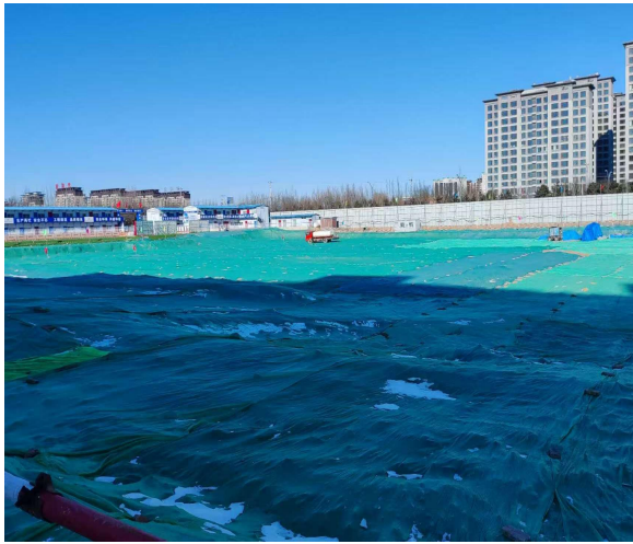
项目区西侧基坑临时苦盖
