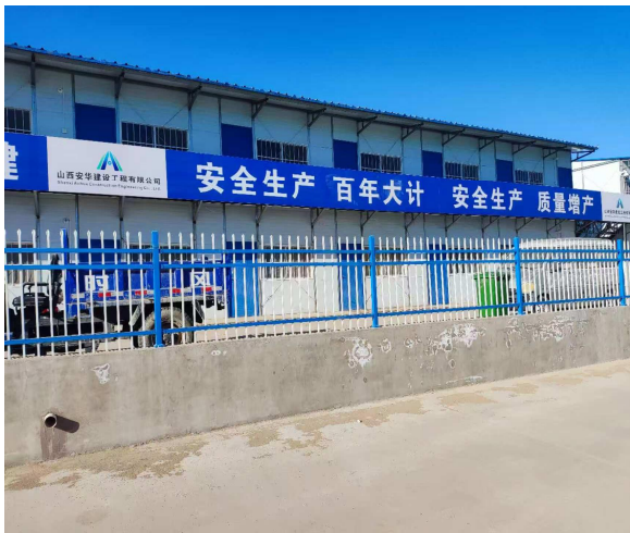
施工临建（施工办公生活区）
