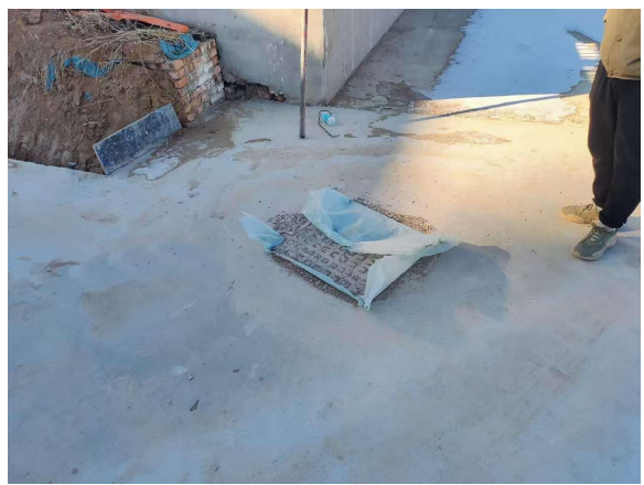
临时（地下）地下沉沙池
