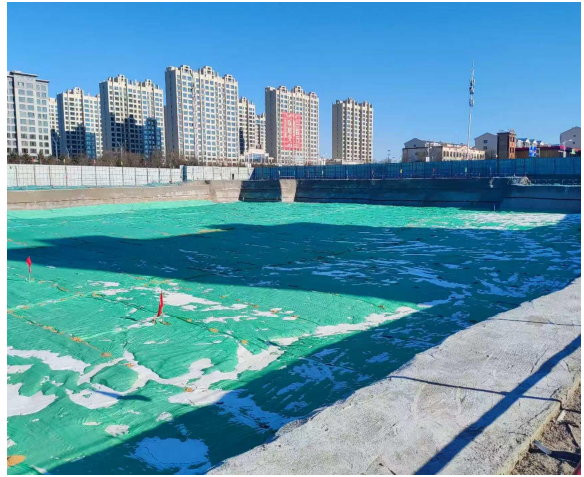
项目区东侧基坑临时苦盖
