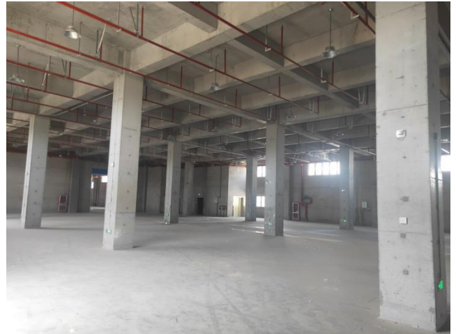
二层厂房现状
